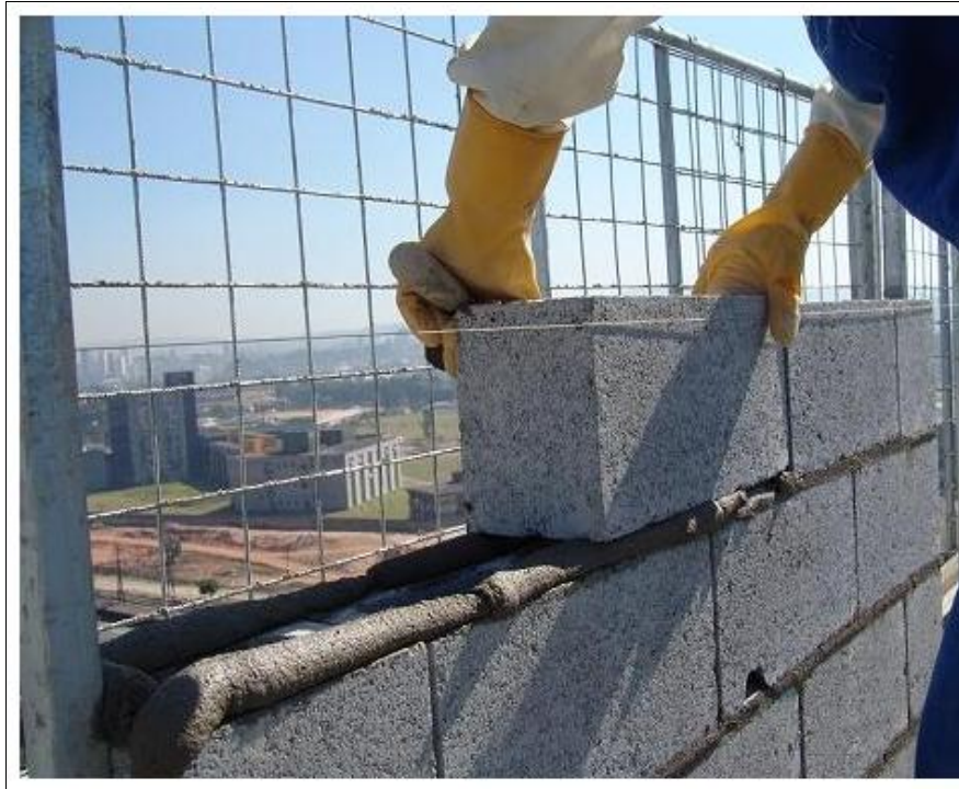
Figura 10: Assentamento de blocos de concreto: juntas devem possuir aproximadamente 1cm. Fonte: (obra24horas, 2006)
