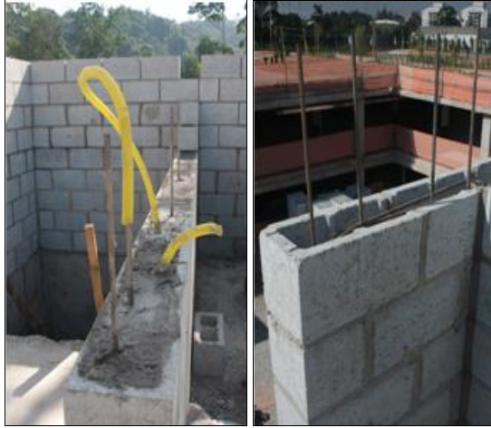
Figuras 11 e 12: Groute e ferragem na alvenaria estrutural. Fonte: Comunidade da Construção, 2011.
