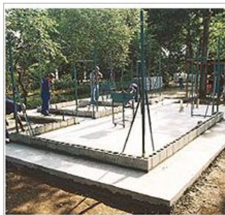
Figura 7: Marcação da primeira fiada para alvenaria de blocos de concreto.
