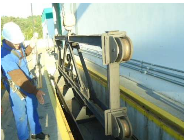
Figura 8: Instalação da comporta ensecadeira utilizando a monovia.
